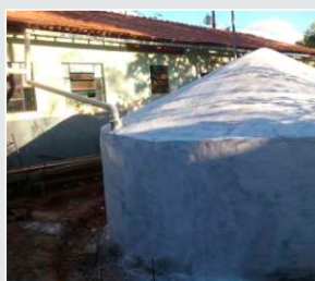
Cisterna - Santa Bárbara
